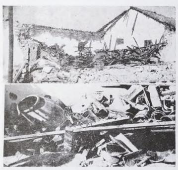
En el estado que se ve en las fotografías, quedó una parte de la finca que da a la calle del Tinte y en la que están enclavadas las bodegas Alarcos, derrumbándose a causa del reblandecimiento de las últimas lluvias.
