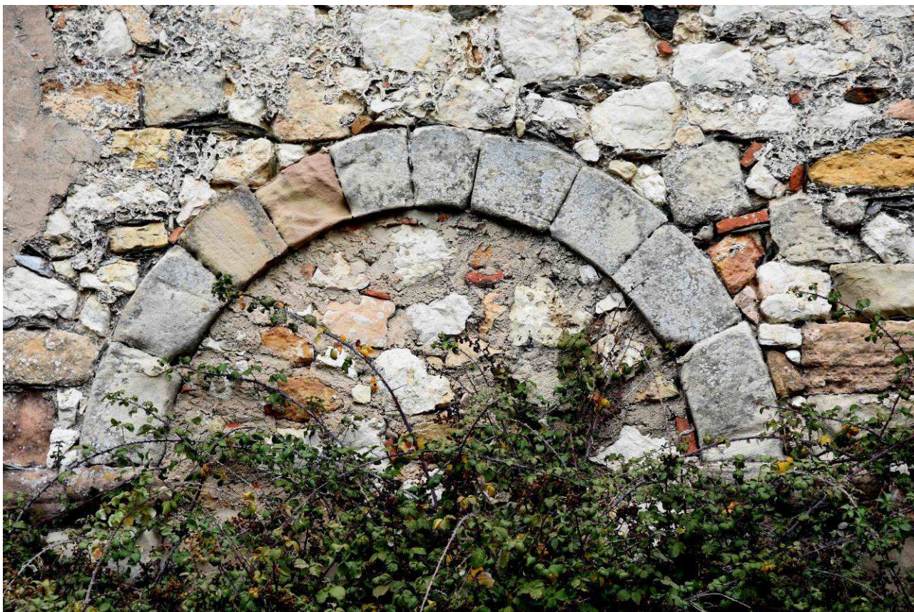
Arco de sillar cegado, sobre los mampuestos del cerramiento amurallado de la cara sur
