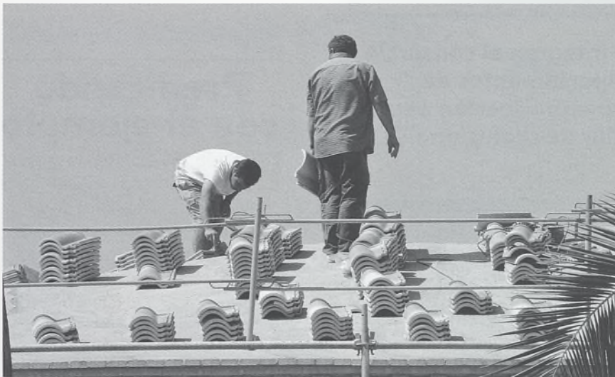
Los aislamientos térmicos de edificios y viviendas y los arreglos de las estructuras son subvencionables dentro del plan de rehabilitación.
