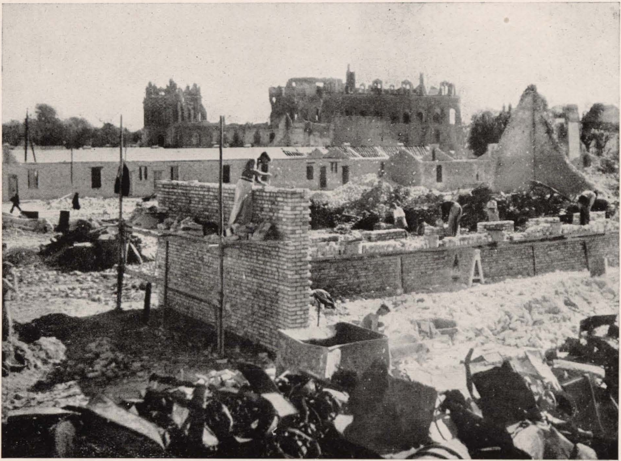
Trabajos de reconstrucción de la ciudad de El Havre.
