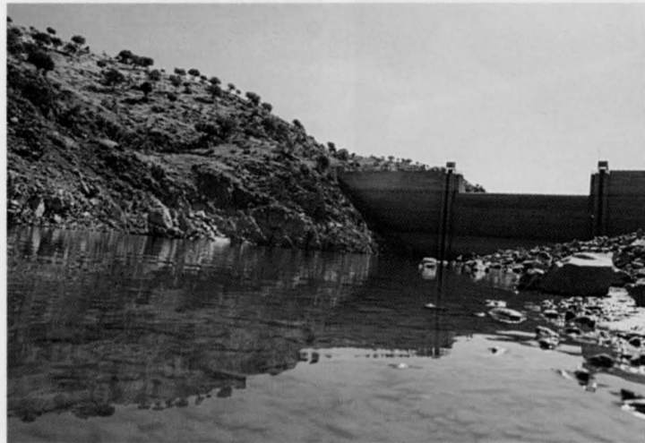
Vista parcial del embalse de Cruces en el río Tablillas.
