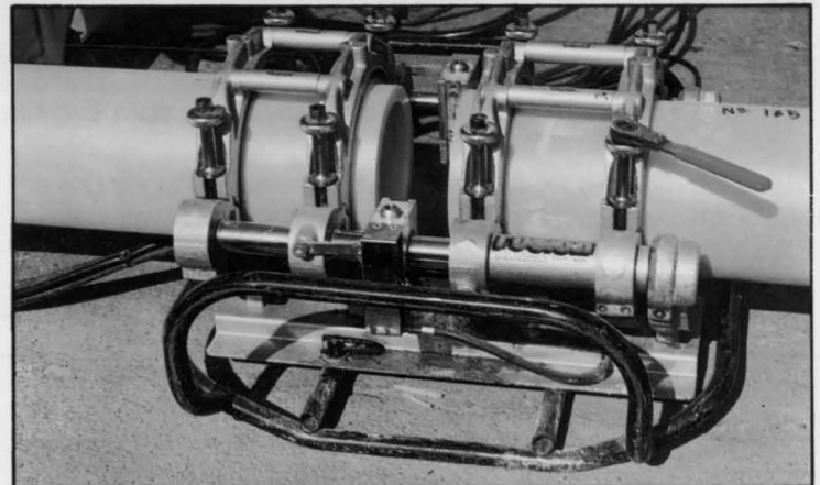
La secuencia fotográfica muestra al Alcalde en el momento de pulsar el botón de la máquina de soldadura automática de tubería en la calle Manzanares.
