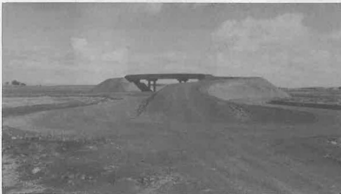
Los accesos a los puentes serán mejorados
