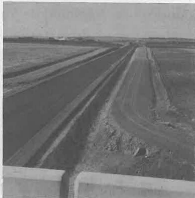
La carretera y los caminos laterales están casi terminados
