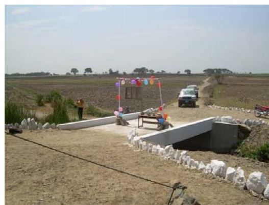
Puente de San Eugenio (Pueblo Nuevo - Perú)
