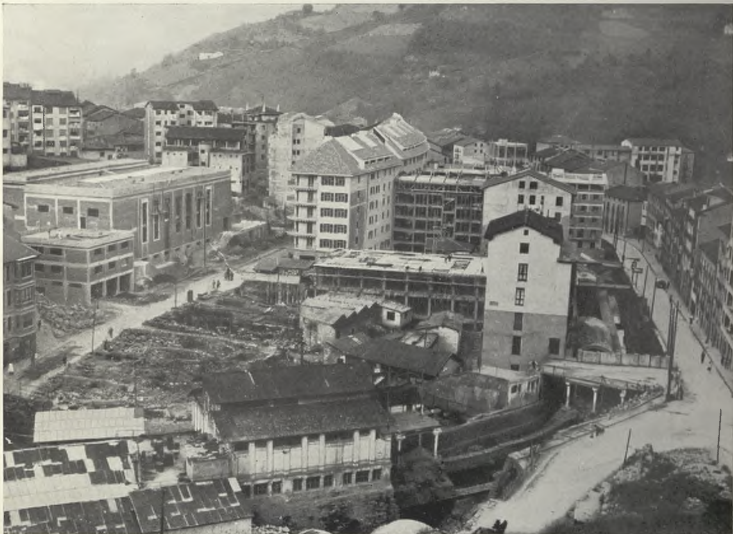
EIBAR.—Terminadas las obras de cubrimiento del río Ego, avanzan rápidamente las obras en reconstrucción. A derecha e izquierda vemos el Bloque de nuevas viviendas y el Mercado, ambos edificios en la calle de María Angela.
