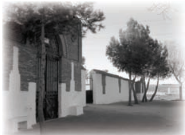
Fachada del actual cementerio - Foto Benjamín de Castro
