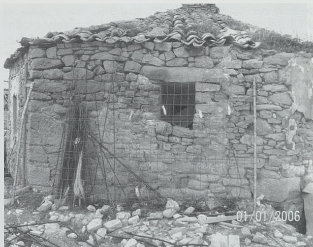
Edificación octogonal. Hipotética torre
