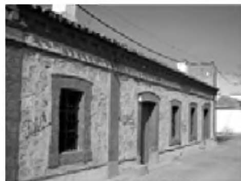
Casilla de camineros sita en la Avda. de Madrid
