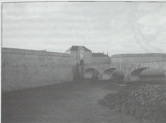
Fig. 7. La frente del fuerte de Blavet. Fotografía del autor
