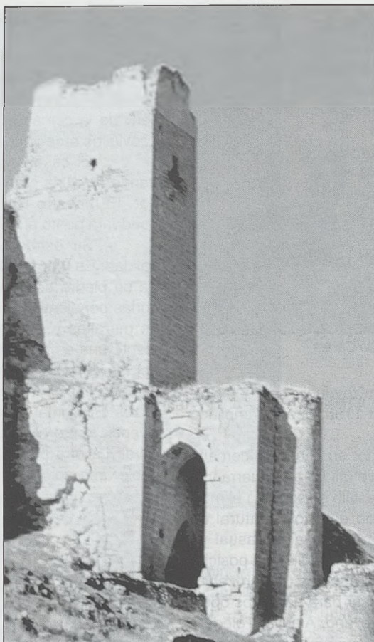
Zorita de los Canes, entrada en el recinto externo
