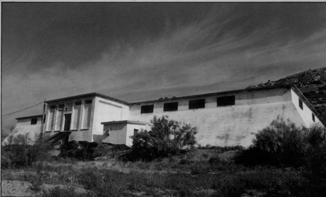
El depósito de agua, construido hace 25 años, padece fisuras y filtraciones
