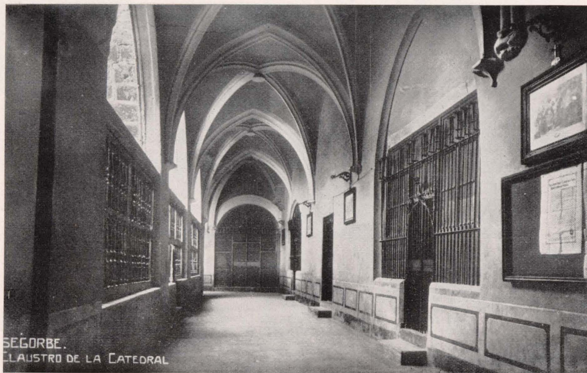
Nave del claustro antes de su destrucción.
