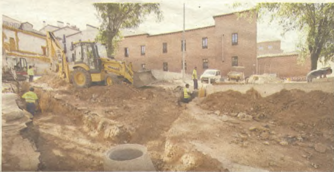
Estado de las obras en la plaza de Dávalos./Eduardo Bonilla
