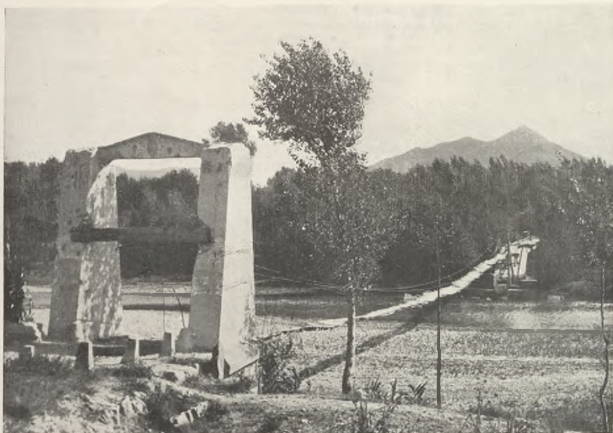
ARTESA DE SEGRE.—Antigua pasarela.
