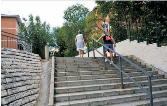
Además de las escaleras hace falta una rampa tan necesaria y mas que la realizada en el lateral del Centro Escuela Adultos.
