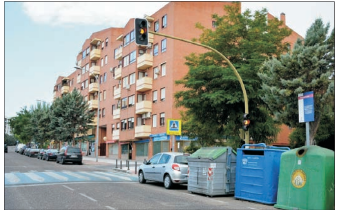
Los setos y contenedores que signifiquen un impedimento visual para peatones y conductores deben ser ubicado o desplazados a un lugar mas idóneo.
