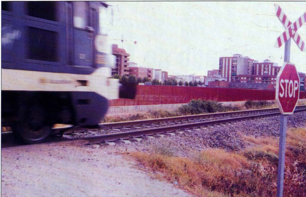
En la imagen se puede apreciar que el peligro del tren es más que evidente. La valla roja es la de la piscina.
