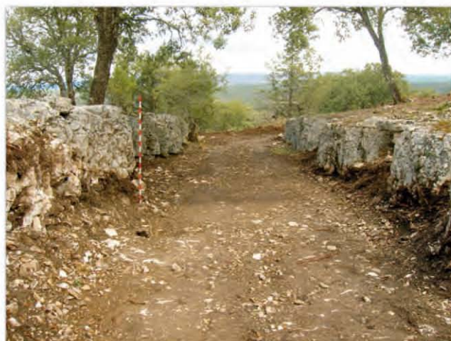
Tramo de foso excavado en Peña Moñuz
