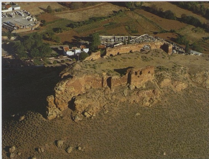
Figura 1: El castillo de La Estrella de Montiel al comienzo de los trabajos arqueológicos y de restauración (año 2013). Fuente: autores
