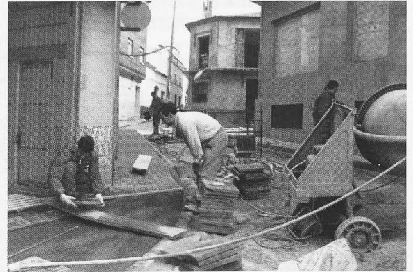
Acerado en calles de la zona centro.
