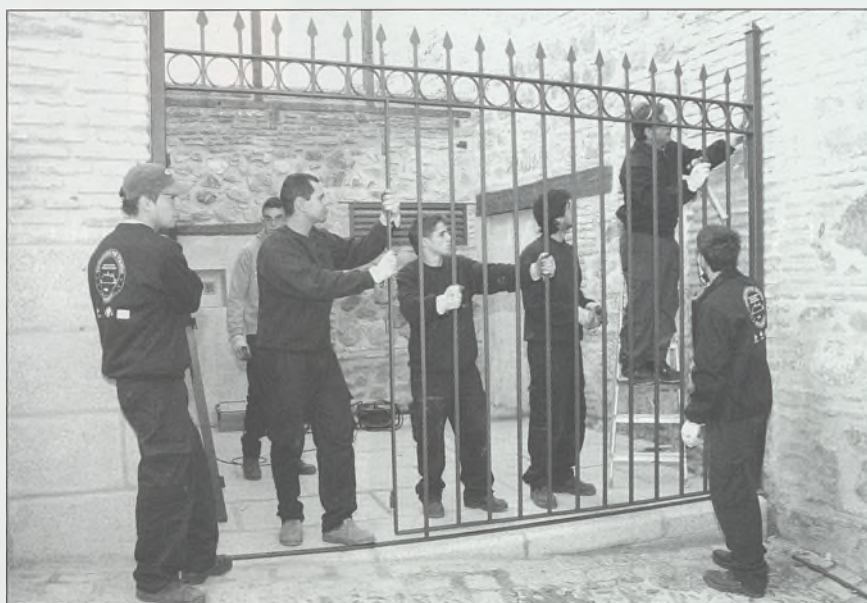
La vivienda adosada a la iglesia de San Sebastián ha sido rehabilitada por la Escuela Taller. Los alumnos de forja colocaban, el miércoles, la cancela.
