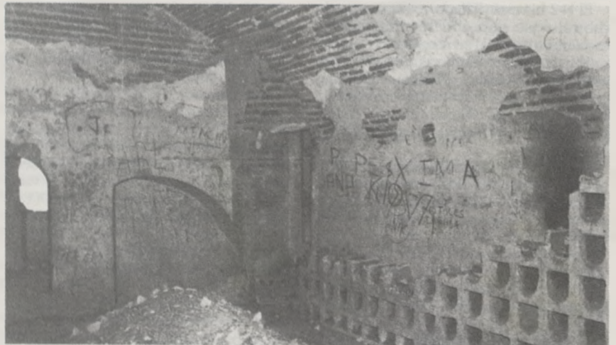
Lám. 9. Vista interior de los paramentos O. y N.
