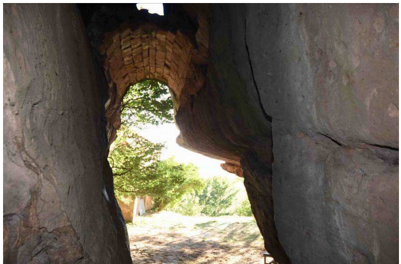
Restos de la bóveda de cañón
