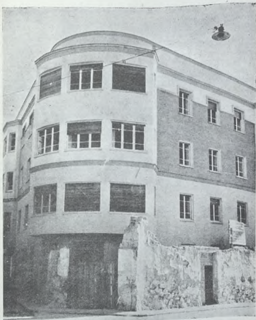
Fotografía del estado actual de la construcción en el solar de la calle General Rey.
