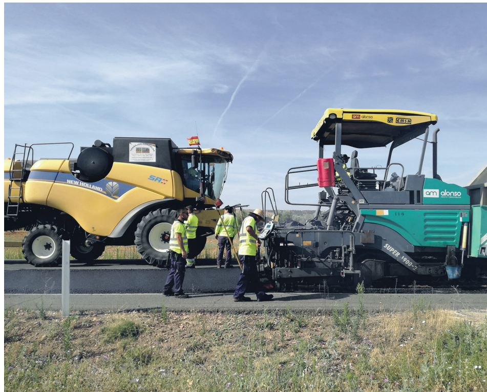
LAS OBRAS PARA MEJORAR EL FIRME DE LA CM-412 / M. G.
