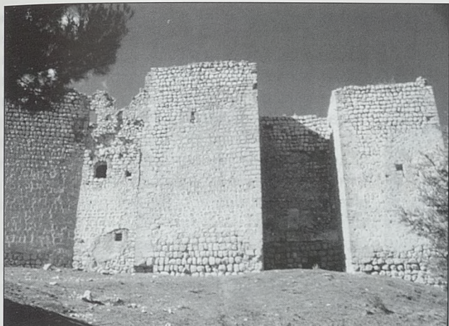
Castillo de Cifuentes, torres que ocultan la entrada en codo
