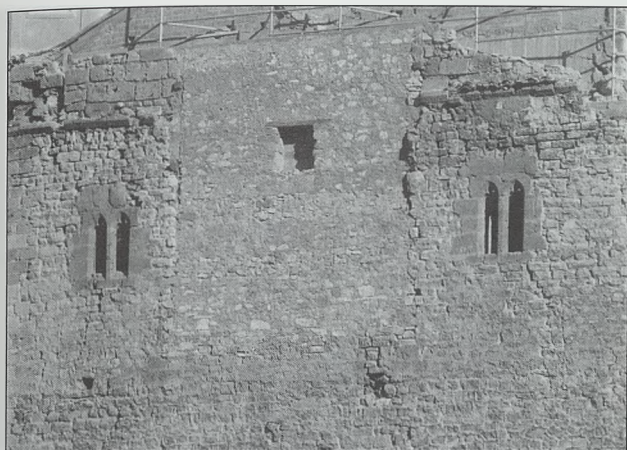
Ventanas y saetera
