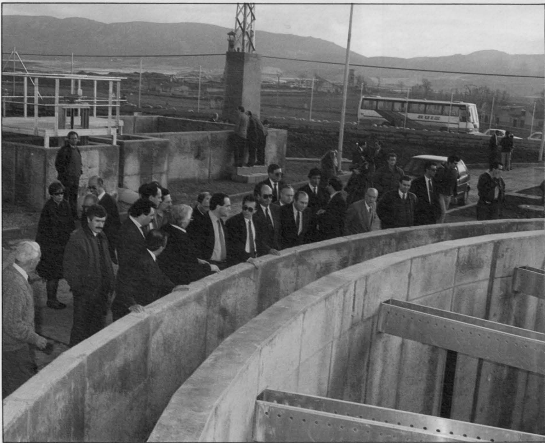
La Depuradora de Aguas Residuales, inaugurada por el Presidente.
