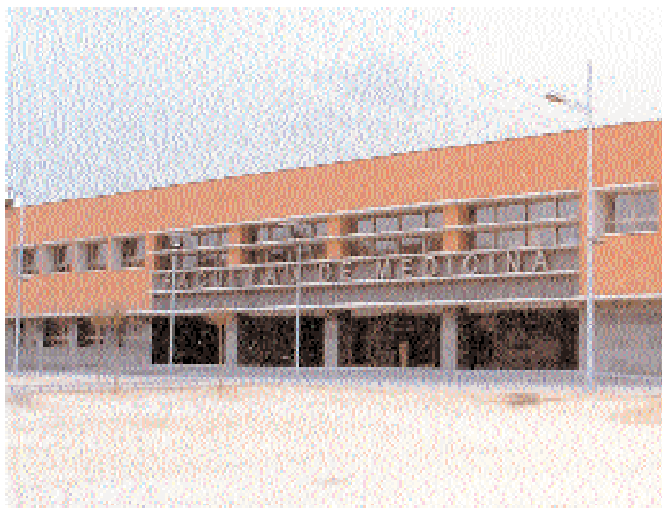
Fachada principal del edificio de la Facultad de Medicina
