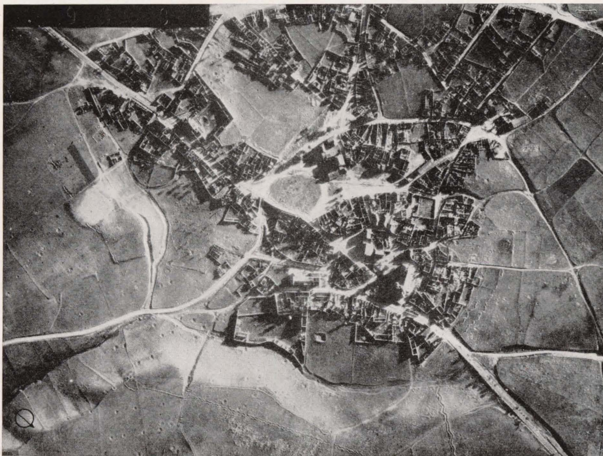
Vista aérea del pueblo destruido.
