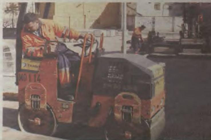
El asfaltado del entorno de Santa María marcha a buen ritmo. / FOTO: JESÚS ROPERO
