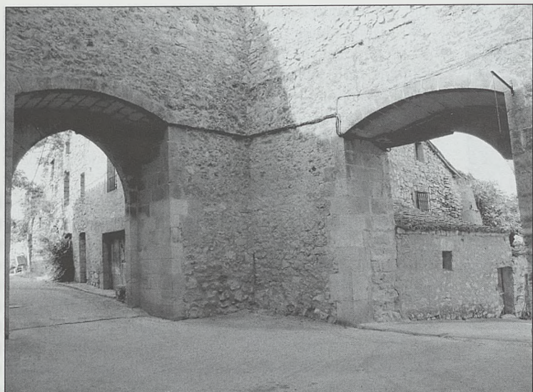
Detalle desde el interior de la villa de Palazuelos
