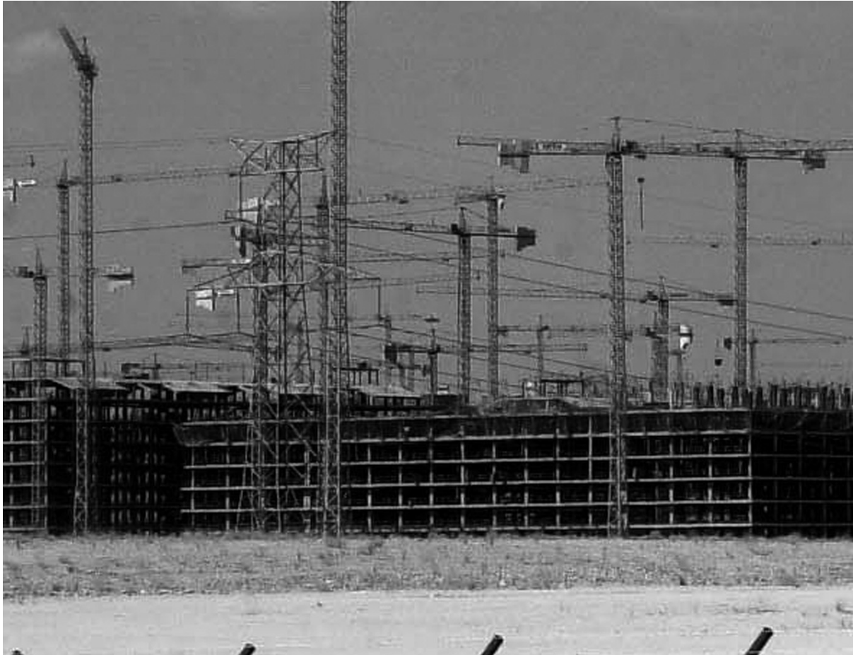
La construcción fue el sector más castigado por las insolvencias.
