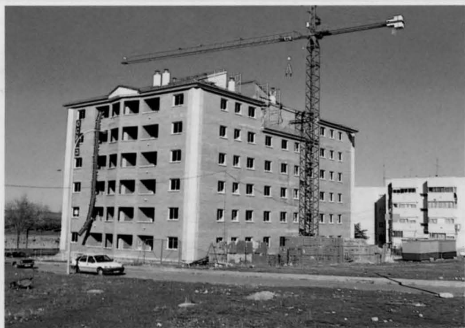
Vista general de uno de los bloques de viviendas que se adjudicarán
