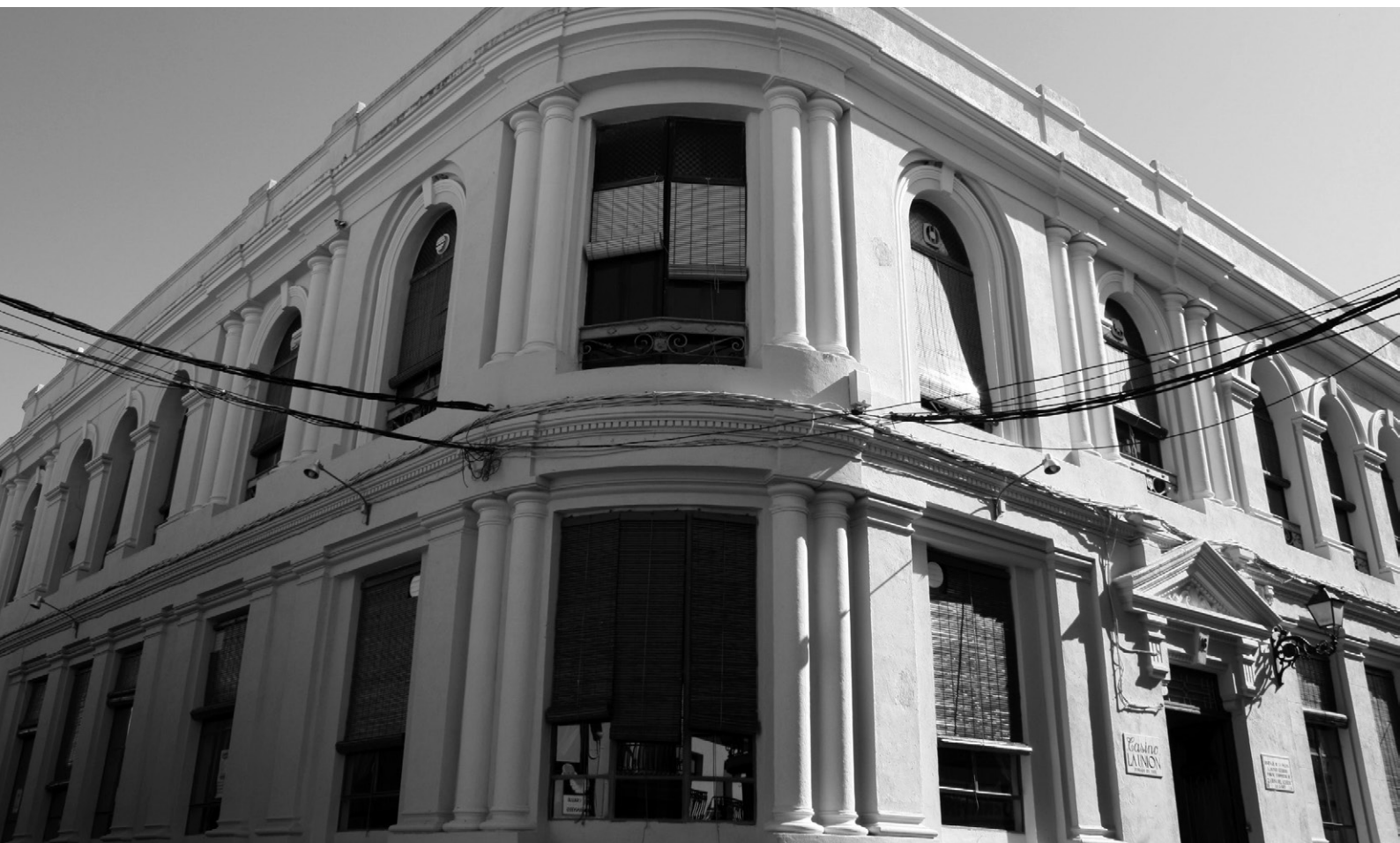
▲ Panorámica de la espléndida fachada del Casino La Unión.
