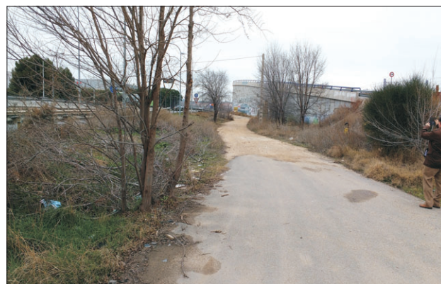
El demandado paseo peatonal y carril bici son otra parte del proyecto.
