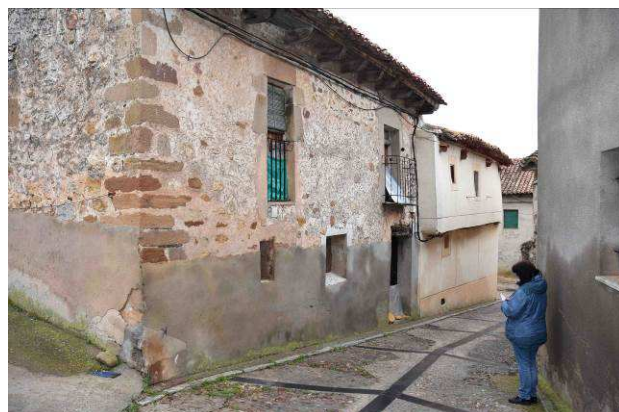
Vivienda en San Gil con esgrafiado de escamas
