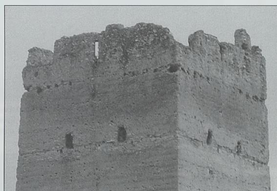
**Fig. 4.** Torre de Mussa (Benifaio). Vista del ángulo suroeste. En los ángulos de la zona subyacente al parapeto superior se muestran los mechinales de las vigas de las buhardas o cadalsos: obsérvese la viga de ángulo y las puertas de acceso a los dispositivos
