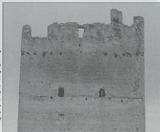
**Fig. 6.** Torre de Mussa (Benifaio). Vista frontal de la zona superior de la cara sur. Obsérvense los mechinales de las vigas de los dos cadalsos de ángulo y, a la izquierda, una puerta de salida al dispositivo
