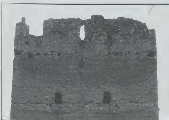
**Fig. 5.** Torre de Mussa (Benifaio). Vista frontal de la zona superior de la cara oeste. Aparecen claramente los mechinales de las vigas de los cadalsos de ángulo y, a la izquierda una de las puertas de acceso
