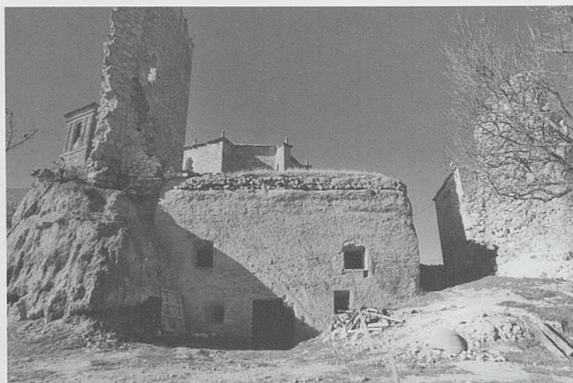
Fig. 7. Detalle de los restos del castillo y de la iglesia de Valfermoso desde el Este. Aljibe en primer término, Torreón a la derecha y torre del Homenaje a la izquierda
