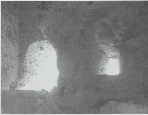
Fig. 24. Torre de Montroy. Vista interna del vano y la setera de la figura precedente
