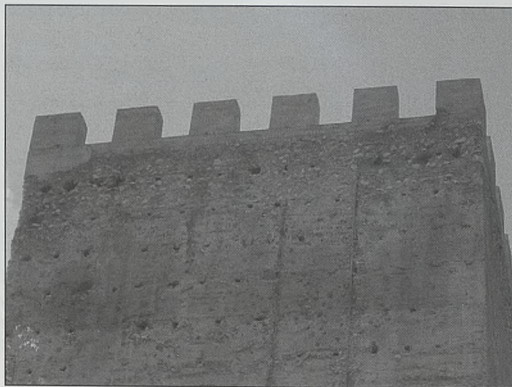
Fig. 30. Torre de Sot de Chera. Vista del lado norte. A ambos lados de la zona alta aparecen sendas hileras de maderos incrustados que son los restos de los suelos de las buhardas de ángulo
