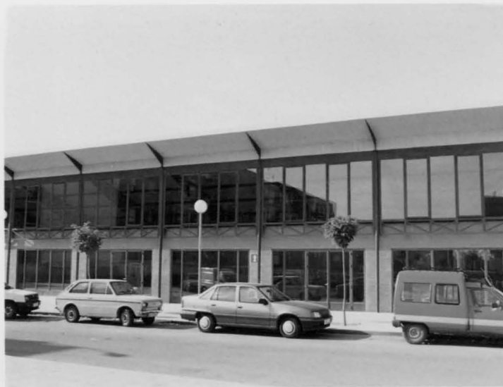
El edificio anexo a la estación del AVE, en la fotografía, será la sede de la Oficina de Promoción
