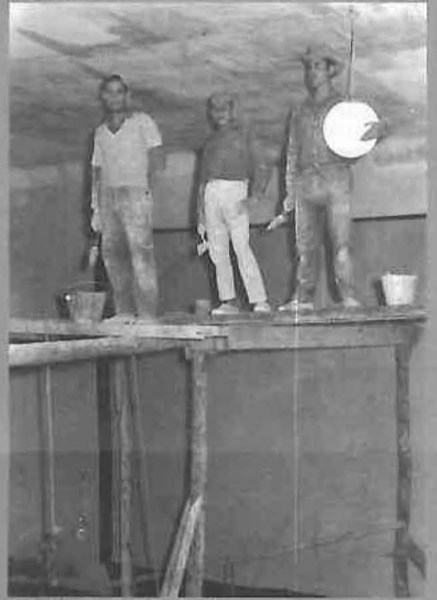
2. Recientemente fue derruido el antiguo cine de invierno, el cine BARGENA. Esta foto recoge los trabajos de pintura realizados en su interior. Era el año 1959.
