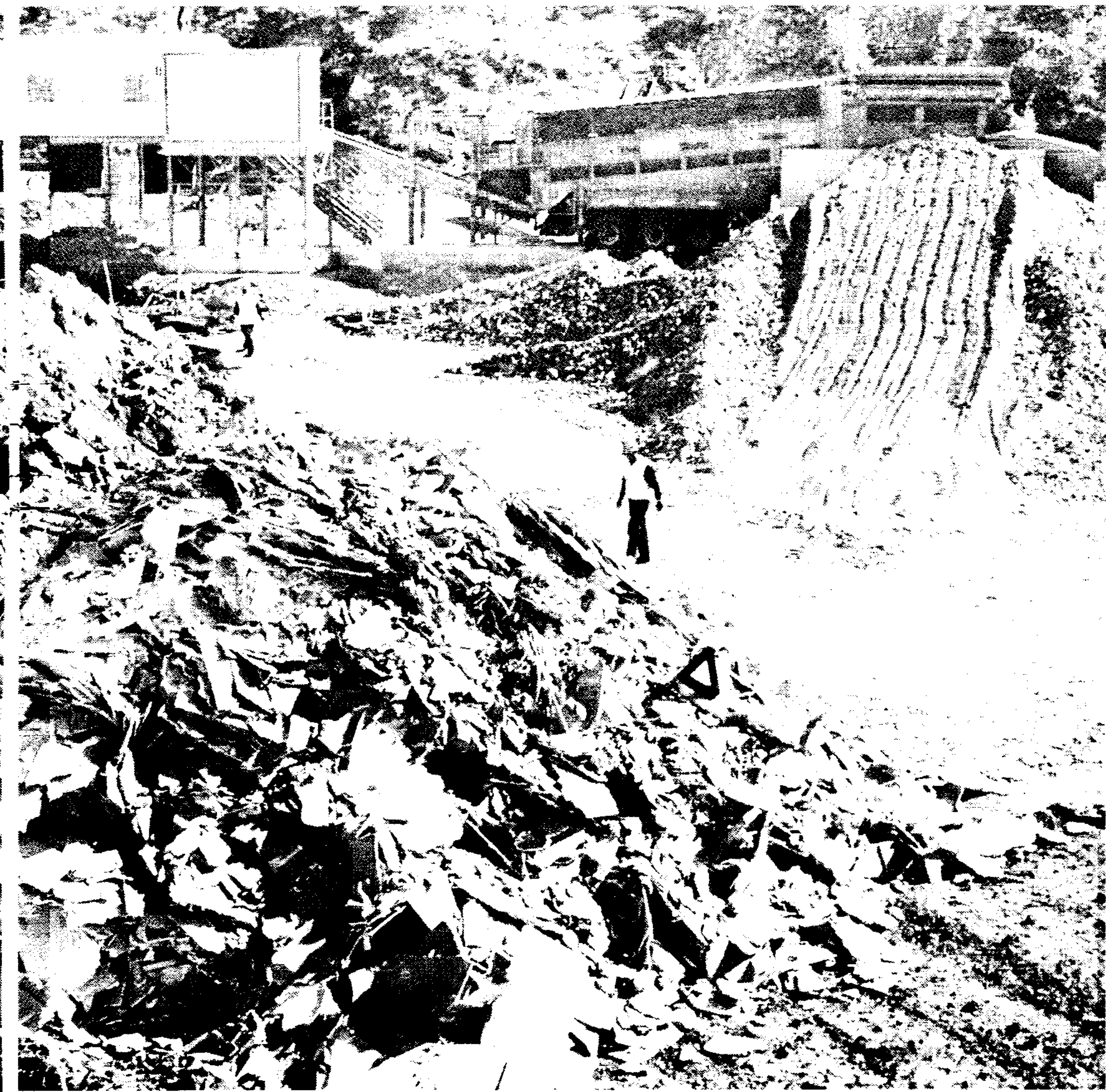
En Castilla-La Mancha se produce más de un millón y medio de toneladas de residuos de construcción ABC
