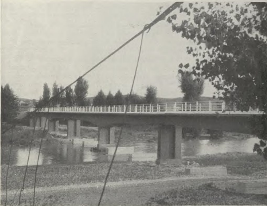
ARTESA DE SEGRE.—Vistas del nuevo puente.
