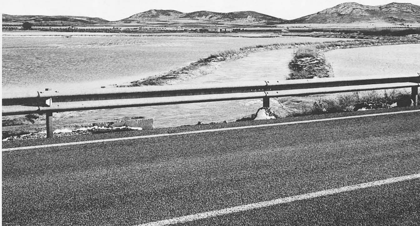
En esta foto se puede apreciar el desbordamiento del Azuer.
