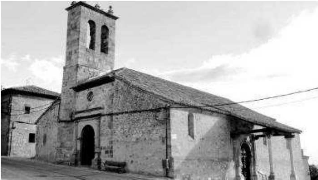
La iglesia de San Gil tras las obras de adaptación a su nuevo ámbito como Muse de Arte religioso
