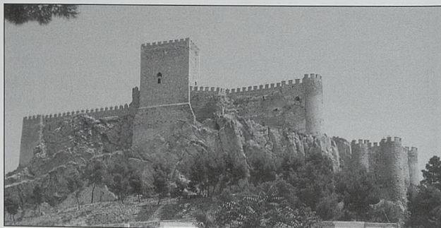
Fachada occidental del castillo de Almansa
